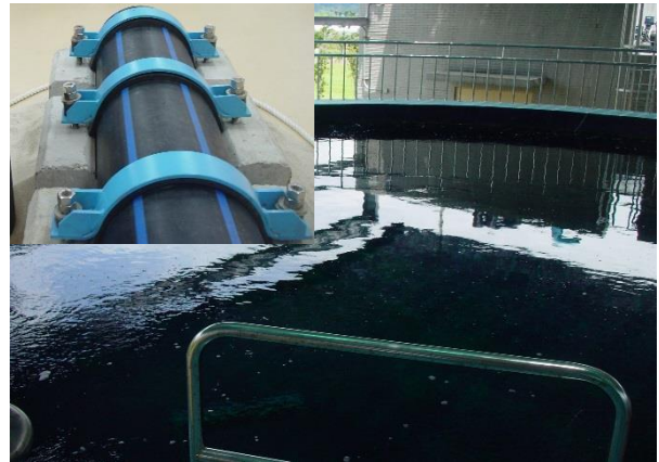
圖二、利用深層海水進行鮭類養殖，左上圖為深層海水取水管以水泥塊固定後，再沉入海底佈設。
