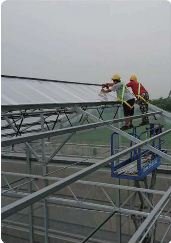
▲ 皆展有限公司F-Clean溫室架設操作過程
